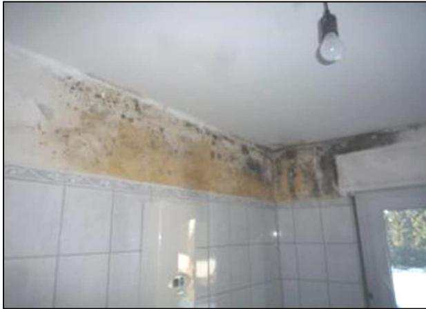
Jetzt ein Schimmelschaden an einer Außenwand mit Blick unter eine Küchenzeile, diesmal verursacht durch einen Baumangel.
